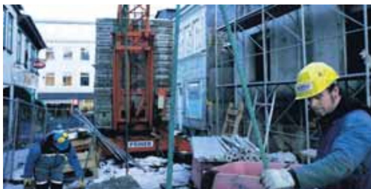
Hér sést frá framkvæmdum við byggingu nýja hótelsins.
