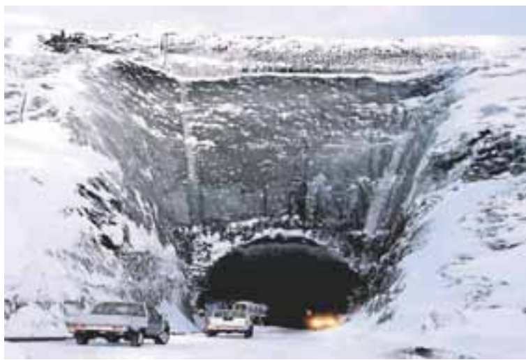
EKIÐ INN Í GÖNGU Borverk Kárahnjúkavirkjunar hefur tafið nokkuð vegna misgengja í jarðlögum, en ofanjarðar ræður árstími og tíðarfarar för. Á vef virkjunarinnar kemur fram að í síðustu viku hafi náðst að bæta ögn við fyllingarefni í Kárahnjúkastíflu og steypa auk þess tæplega 1.500 fermetra af vatnskápu stíflunnar.
