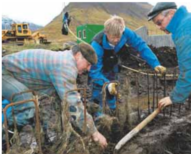
BRÚARGERÐ YFIR FJARÐARÁ Lokið hefur verið við gerð nýrrar brúar yfir Fjarðará við Siglu fjörð. Brúin mun tengjast vegi sem mun liggja að fyrirhuguðum Héðinsfjarðargöngum. MYND/VILHELM
