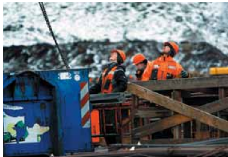
BYGGINGAFRAMKVÆMDIR Ístak leigði fjórtán verkamenn í góðri trú enda verkefni næg. Þessi mynd er tekin af verkamönnum við framkvæmdir á Helliðshéiði.
