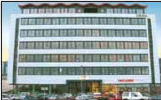
Suðurlandsbraut 12, Reykjavík Skrifstofuhúsnæði á 2. hæð - 110 m 2
