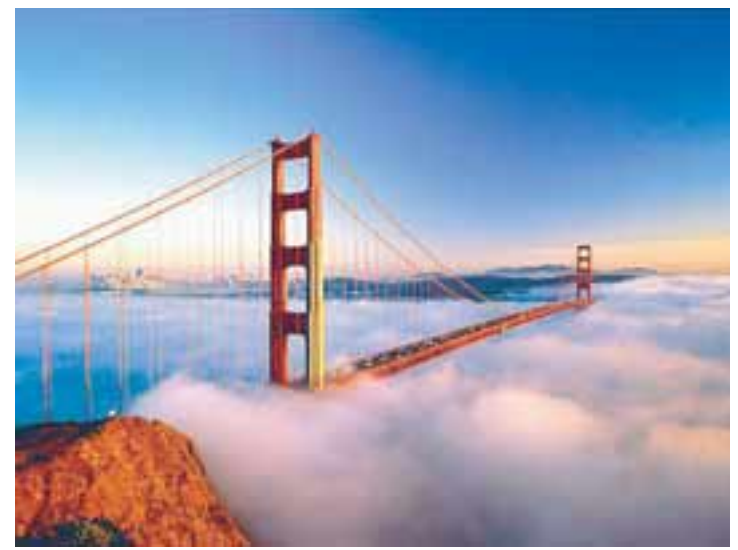
Golden Gate-brúin við San Francisco í Bandaríkjunum er ein frægasta brú veraldar. Hún var reist árið 1937 og er 2,7 kílómetrar á lengd.
