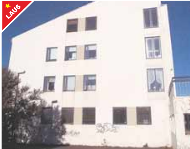
DALSEL, SELJAHVERFI . Glæsileg, opin og björt 90,1fm 3ja herbergja íbúð á jarðhæð í fjölbýlishúsi sem hefur verið klætt að utan. Sérlega fallegt nýtt parket á íbúðinni. Eignin skiptist í: Gang, stofu, borðstofu, eldhús, geymslu/þvottahús, hol, 2 herbergi og bað. Sam. þurrkerherbergi og hjóla geymsla. ÍBÚÐIN ER LAUS TIL AFHENDINGAR STRAX. V-15,9millj. (3847)
