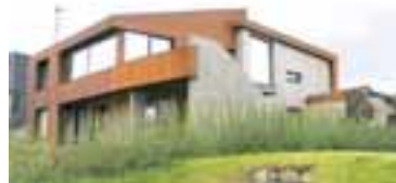
Hér sést húsið að neðan og hvernig steypa hefur verið notuð í bland við kortenstálið.
