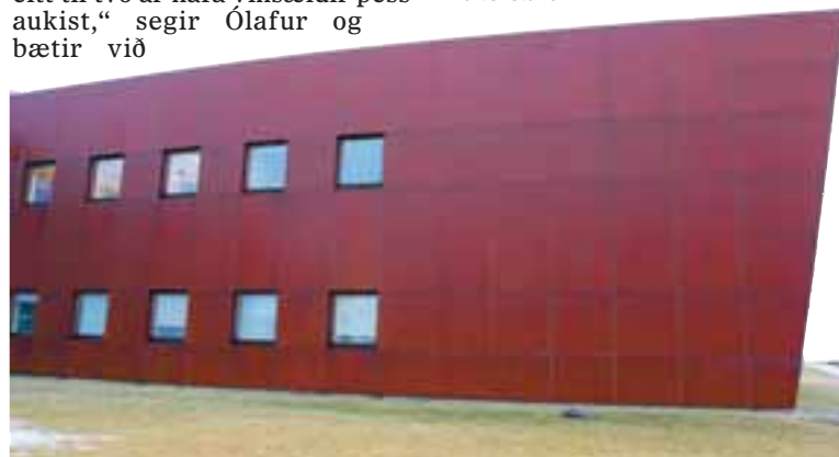
Víkurskóli er klæddur kortenstáli að hluta, og hér má sjá heilan vegg sem er klæddur stálinu.
