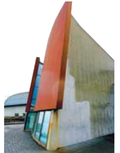
Hér sést í hliðina á stóri kortenstálplötu sem þekur hluta Víkurskóla.
