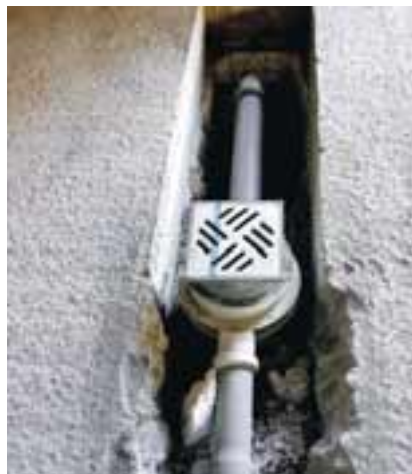
Oft þarf að brjóta upp vegg og gólf til að komast að lögnum.
