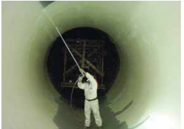
Tæringarvarnarefnum er sprautað í rörin.
