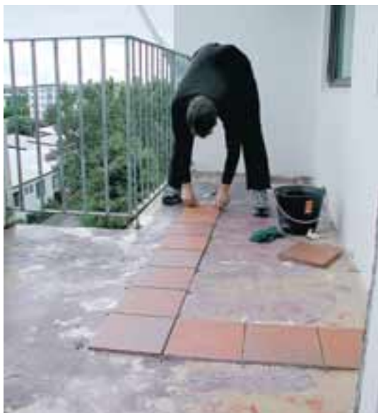
Svalirnar undirbúnar fyrir flísalögnina. Það þarf að þrifa gólfið vel og slétta allar glufur.
