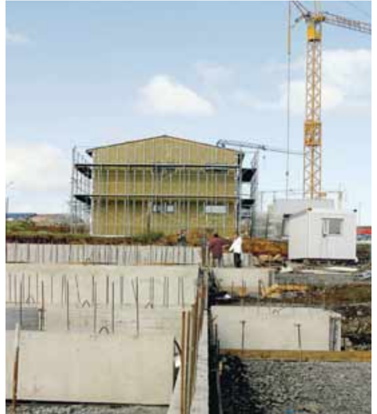
HÚSBYGGING Hækkun á fasteignaverði hefur aukið verðbólgu.
