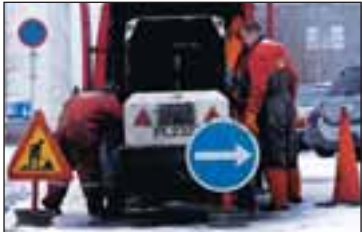
VIÐ HOLRÆSIN Í MIÐBÆNUM Unnið er að því að lengja líftíma holræsanna í miðbæ Reykjavíkur.
