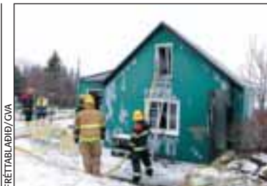
KÁRSNESBRAUT 7 Húsið er mikið skemmt ef ekki ónýtt.
