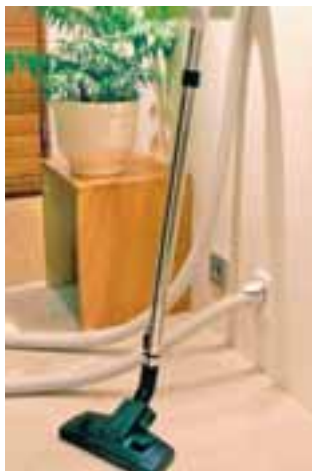
Stútar eru teknir út úr veggjunum fyrir ryksugubarkann, þannig að einungis þarf að færa barkann milli herbergja.
