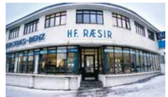
Ræsihúsið við Skúlagötu.
