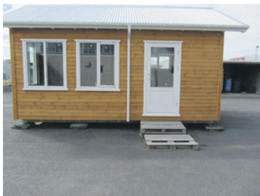
15663 Timburhús nr. 18 sem er 25,0 m 2 að grunnfleti.
