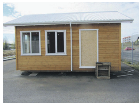
15664 Timburhús nr. 19 sem er 25,0 m 2 að grunnfleti.
