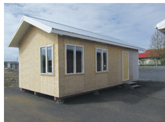
15665 Timburhús nr. 20 sem er 32,4 m 2 að grunnfleti.
