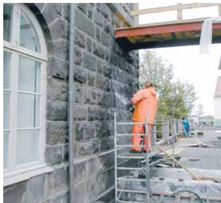
Hér er unnið við Alþingishúsið.
