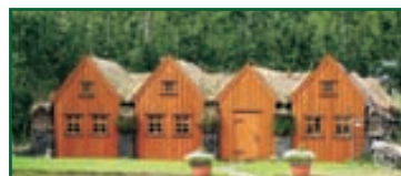
Íslandsbærinn við Hrafnagil Torfbær byggður árið 1997 sem stendur á 2005 fermetra eignarlóð. Húsið er allt byggt að upprunalegri mynd, veggir eru klæddir panil og á gölfum eru timburfjalir. Húsið skiptist í forstofu, stóran sal með borð og stólum fyrir 70 manns, stofu með kaminu, eldhús og salerni. Stærð 135fm Verð 25millj
